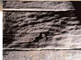
Detail der in Blockbauweise aus mächtigen Eichenspaltbohlen zusammengefügt Brunnenkästen.
